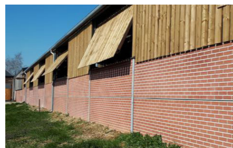
Aménagement d'un volet articulé (CA de l'Aisne)
