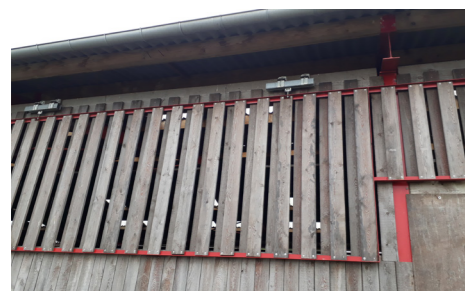
Aménagement d'un bardage ajouré coulissant (IDELE)
